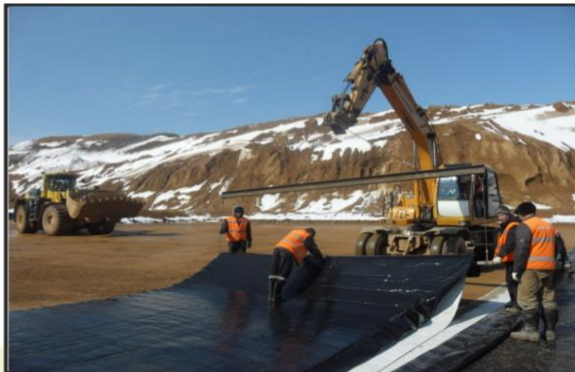
Рис. 3 Укладка бентонитового мата
