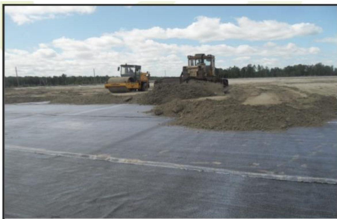
Рис. 6 Устройство обратной засыпки
