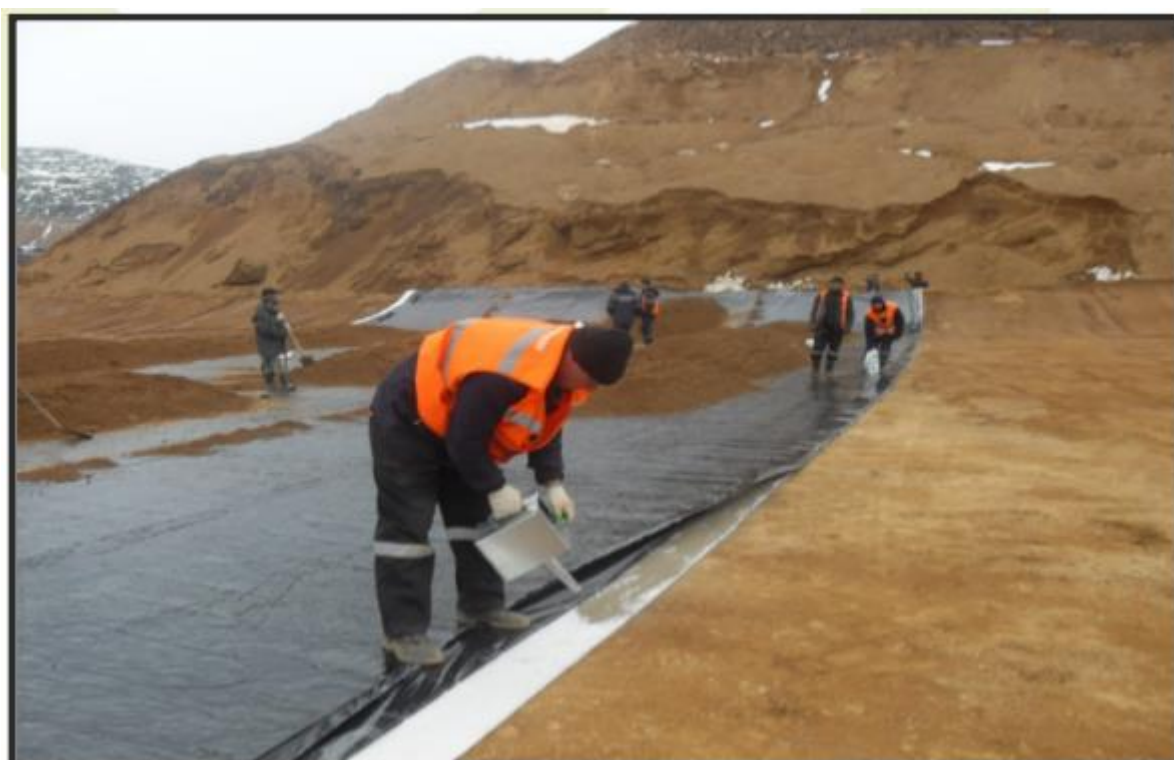
Рис. 4. Просыпка зоны нахлеста бентонитовыми гранулами
