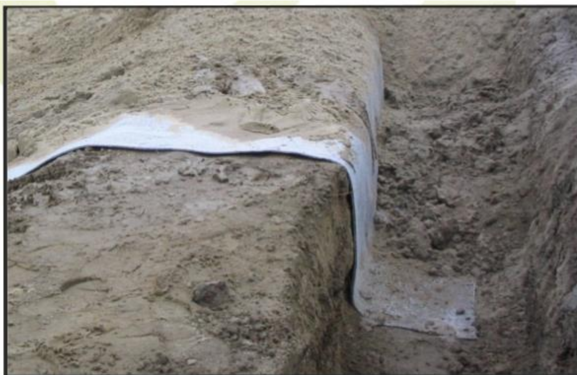
Рис. 2 Устройство анкерного замка
